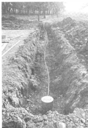
Fig. 5 Mise en place d'un tassomètre
