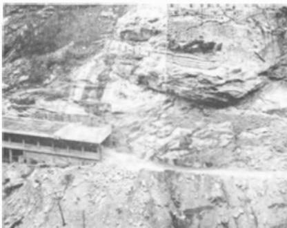
Fig. 10 N9 Simplon Baji-Krachen - Situation après le deuxième minage
