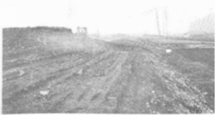
Fig. 7 Remblai autoroute km 44330, enlèvement de la surcharge
