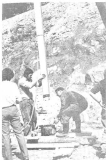
Fig. 18 Mise en place du gainage du tasseomètre à corde vibrante
