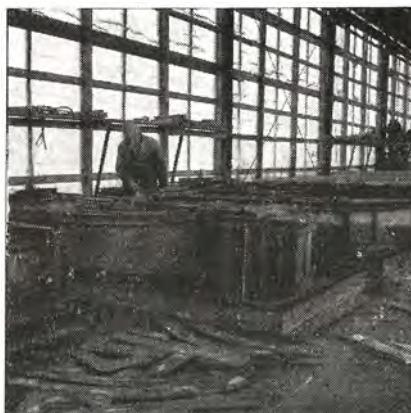
**Abb. 1** Fabrikation der Tübbinge in der Halle. In den Stahlschalungen werden die einzelnen Elemente jedes Rings betoniert und nach vierundzwanzig Stunden ausgeschalt.
