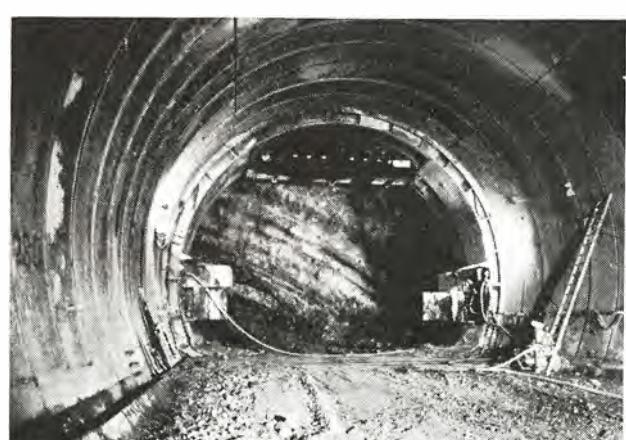
**Abb. 3** Schild Vorort. 7 Hydraulikpumpen, Druckring, eingebaute Tübbinge, Injektionsgerät.
