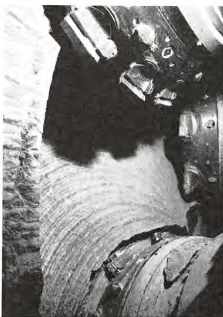
Bild 4. Ausbruchmaterial in natürlicher Schüttung, Stückgrösse im Vordergrund 20—30 cm
