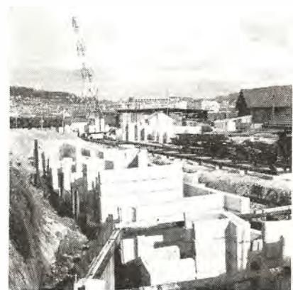
**Fig. 2** Stocks de «tubings» sur le chantier
