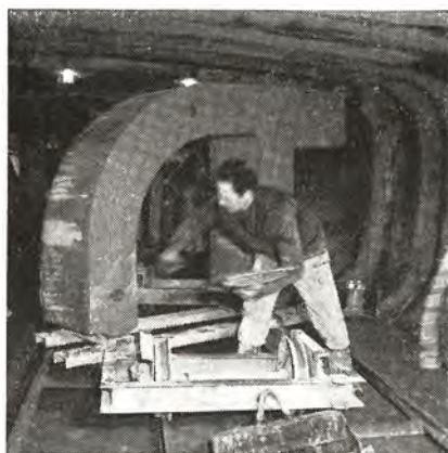
**Abb. 6** Aufziehen des Verbundmörtels auf der Seitenfläche eines Tübbings.
