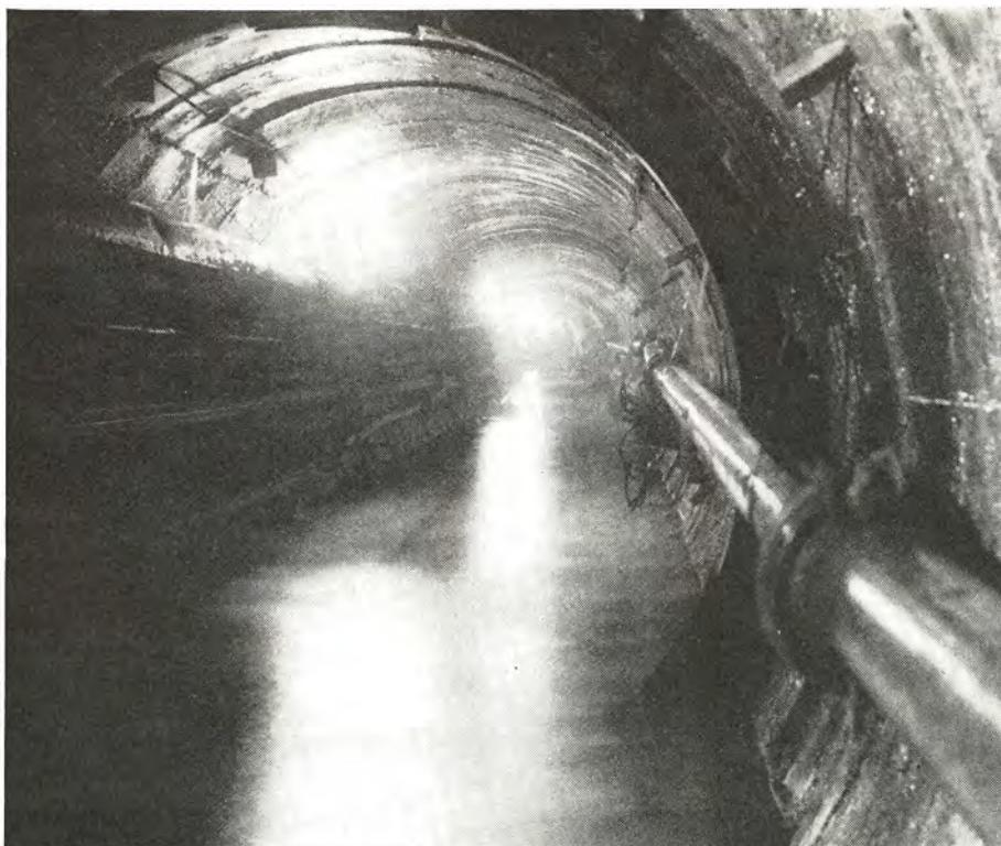
Abb. 14 Schildstrecke während des Baus. Beachtenswert ist die starke Wasserführung im Stollen. (Foto Blenio-Kraftwerke AG)
