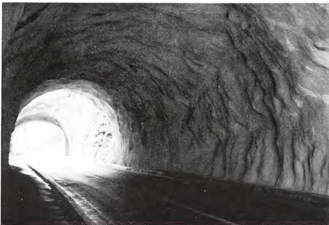
Bild 9. Tunnel an der Axenstrasse mit Gunit-Verkleidung
