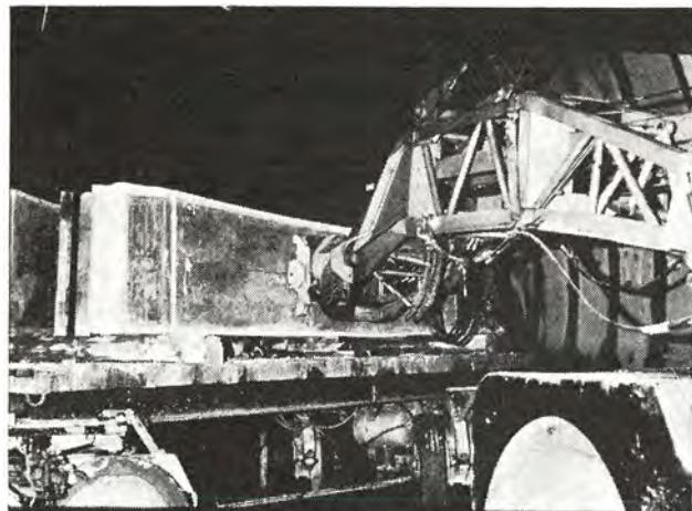
**Fig. 4** Prise des voussoirs sur le véhicule d'aménée; grue de 30 tonnes à pince hydraulique.
