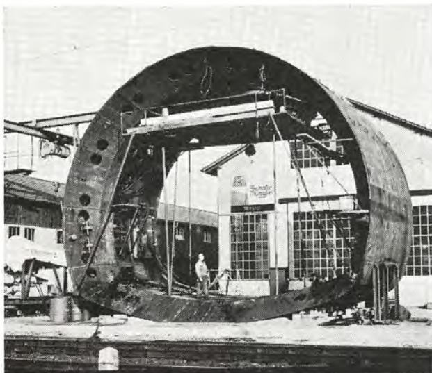
**Abb. 1** Bareggsschild Werkmontage
