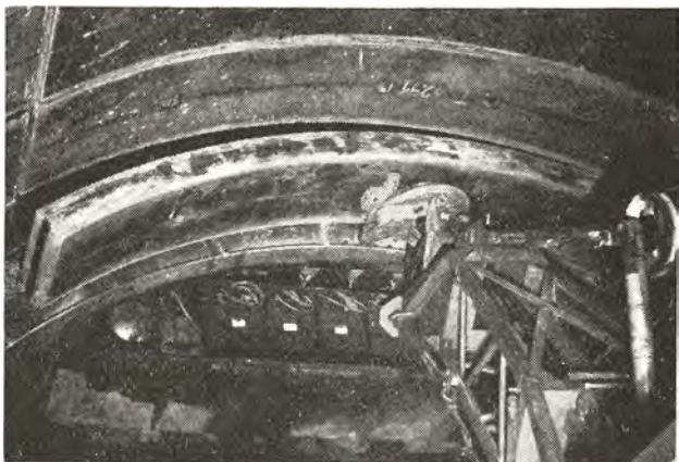
**Abb. 6** Einsetzen des Scheiteltübbings. Mit dem Einfügen des Schlussteins ist der Ring geschlossen.
