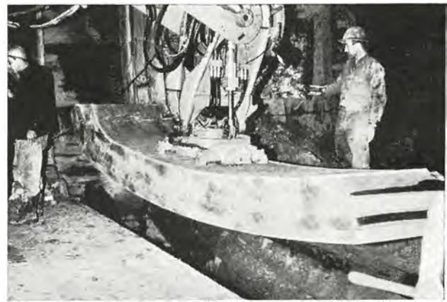
**Fig. 5** Mise en place des voussoirs inférieurs, à l'intérieur du bouclier.
