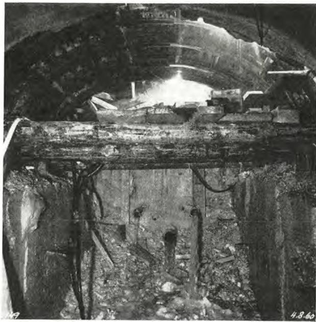
Abb. 7 Herstellung der Kammer für die Schildmontage. (Foto Blenio-Kraftwerke)
