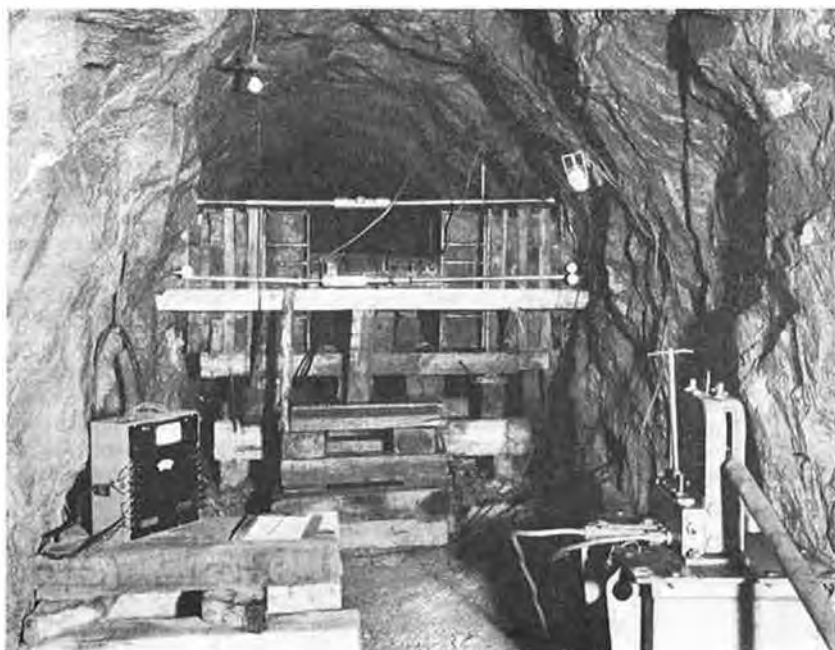
Bild 1. Belastungseinrichtung zur Felsverformungsmessung in einem Sondierstollen der Staumauer Verzasca. Im Vordergrund rechts die Oeldruckpumpe, links die elektronische Messbrücke mit den Verbindungskabeln zu den Druckdosen
