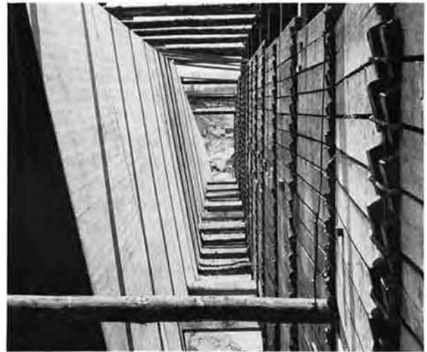
Abb. 8. Detail der Rühlwand als Bohlenwand mit gekeilten Spezialbügeln
