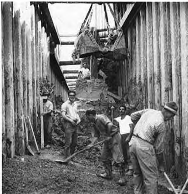
Abb. 10. Aushub zwischen Spundwänden
