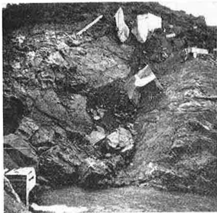
Bild 3. Einzelheiten des linken Widerlagers und des linken Hanges. Am abgestürzten Block sind fest mit dem Beton verbundene Felsteile erkennbar
