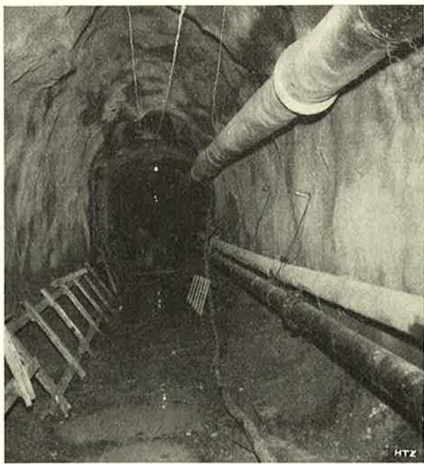
Abb. 3 Vortriebssicherung durch Spritzbeton in gebrächem Gebirge (KW Ackersand II).
