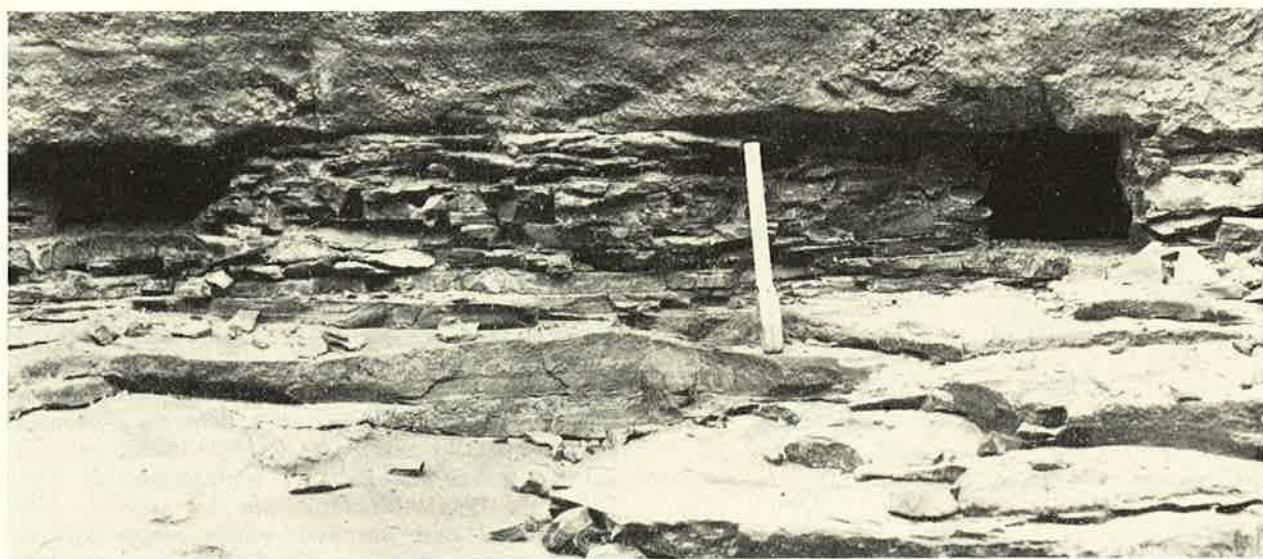
Abb. 22 Bogenstaumauer Cambambe. Nahsicht der waagrechten Verwerfungsspalte Abb. 21. Das Füllmaterial ist hier steinhart, aber irgendwo ist doch immer eine millimeterdünne Tonschicht, die als geschmierte Gleitfläche zu fürchten ist.
