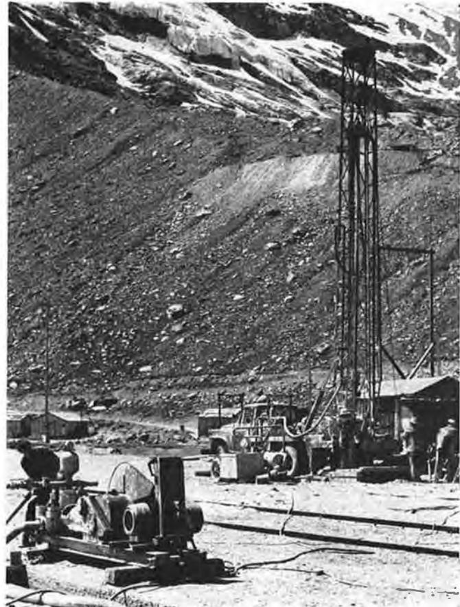
Bild 22. Bohrgerät Rotary Keystone-Frank mit Pumpe
