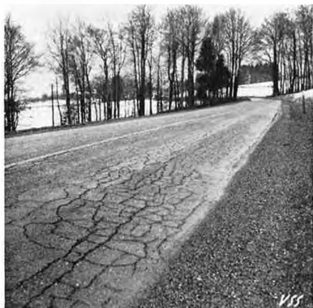
Fig. 2. Fissuration généralisée en «peau de crocodile» due à l'insuffisance de la force portante de la chaussée au dégel. Route Savigny-Oron
