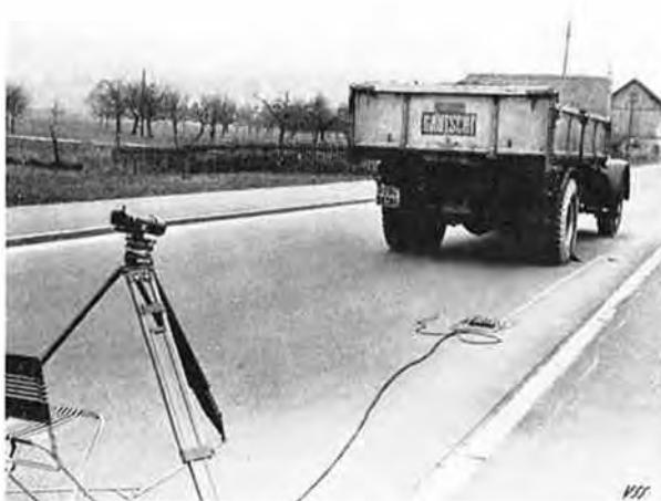
Abb. 7. Durchbiegungsmessung einer Strassendecke mit Präzisionsnivelllement
