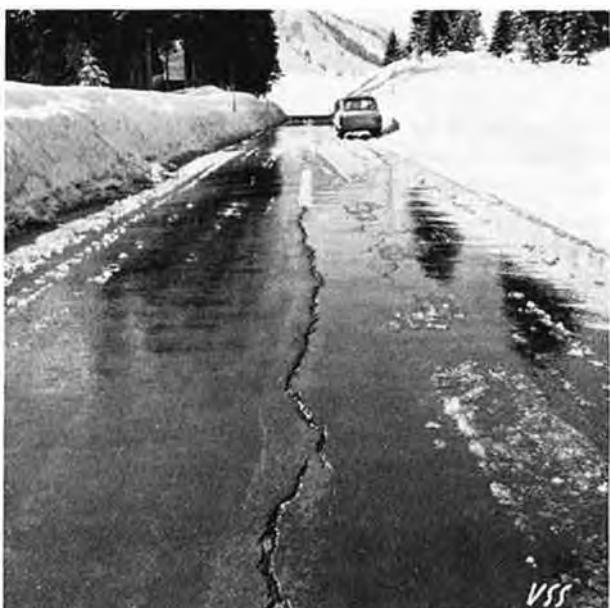
Fig. 1. Fissuration longitudinale par gonflement dû aux lentilles de glace pendant le gel. Route des Mosses, 1400 m d'altitude. Tapis et gravier concassé 8 cm; fondation 50 cm
