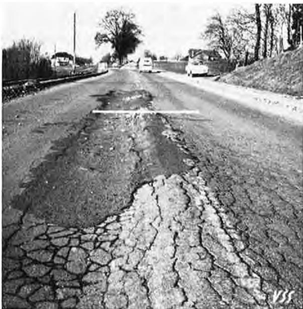
Fig. 3. Formation d'ornières après la fissuration généralisée au dégel. Route Etagnière-Assens
