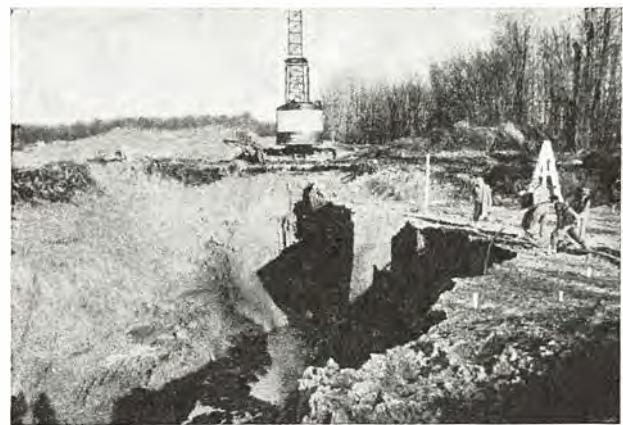
Fig. 10. — Canal du Saint-Laurent. Tranchée d'essai.
