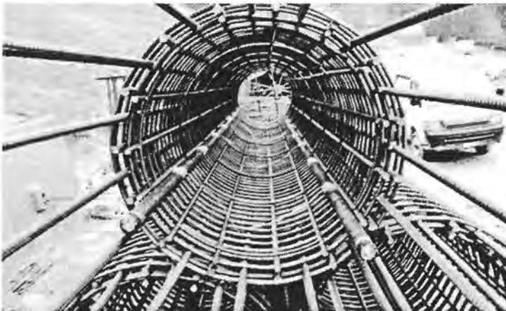
**Bild 5: Pfahlarmierung mit den Trivec-Messrohren**
