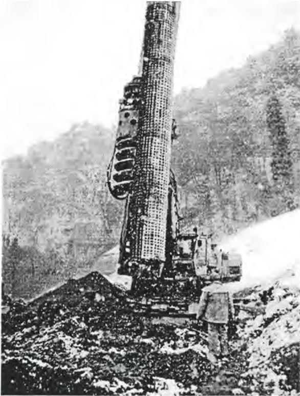
**Bild 7: Versetzen der Pfahlarmierung mit den Trivec-Messrohren**
