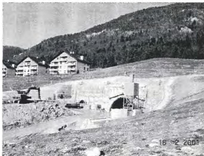
Figure 10 : Photos de l'excavation du portail de Moutier
