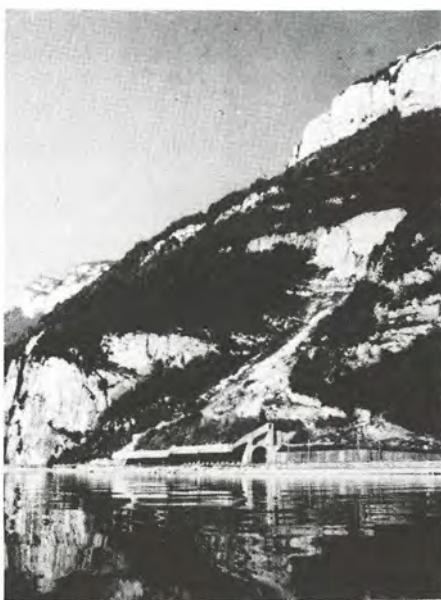
Figure 25 - Lac du Bourget (Savoie). Protections contre les éboulements rocheux.
