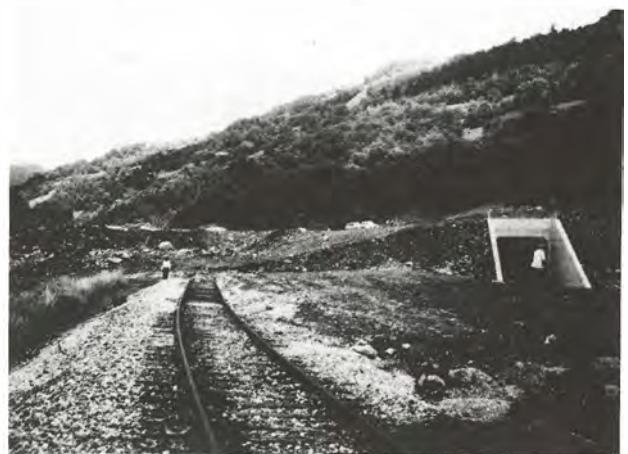
Figure 8 - Coulée boueuse de La Ravoire de Bourg-Saint-Maurice (Savoie). La coulée a coupé la voie ferrée qui sera placée dans la tranchée visible sur la droite.
