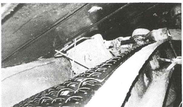
Fig.3 Mesure des contraintes dans le béton : mise en place des capteurs et fixation sur les tôles de l'intrados. On distingue, en haut, la jupe du bouclier et, à gauche, le béton de la voûte. (photo M. Odier)
