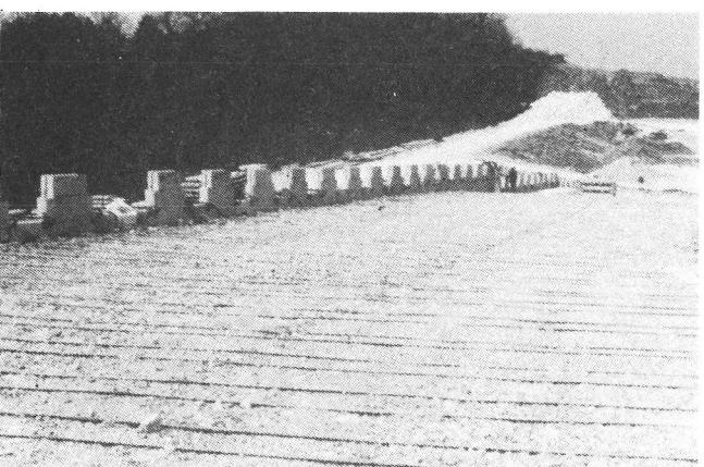
Photo 12 : plan d'armatures en place
