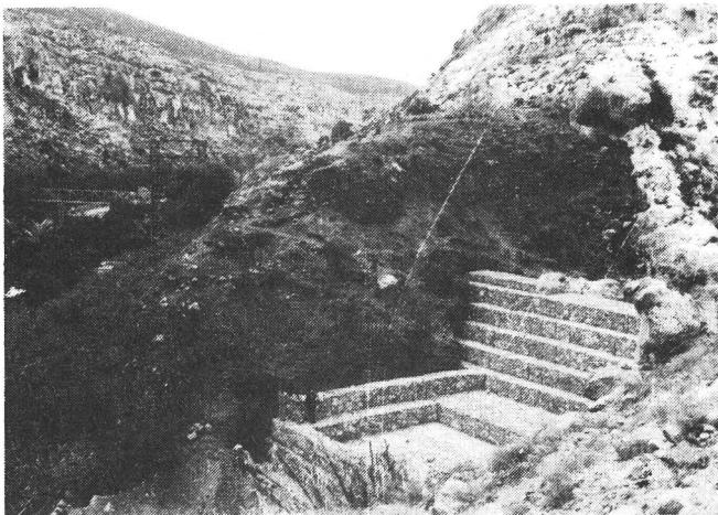
Bild 10: Klassisches Beispiel einer Sperre zur Regulierung eines Bergbaches. Wie man sieht, sind das Tosbecken und der Mittelteil der Sperre vollständig aus Gabionen gebaut.
