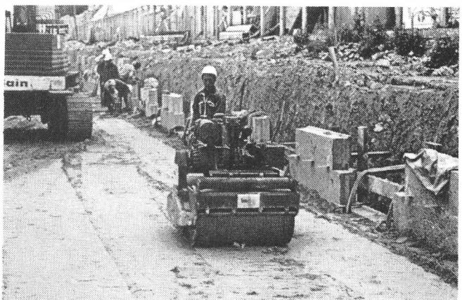
Photo 14: Verdichten bei der Verkleidung
