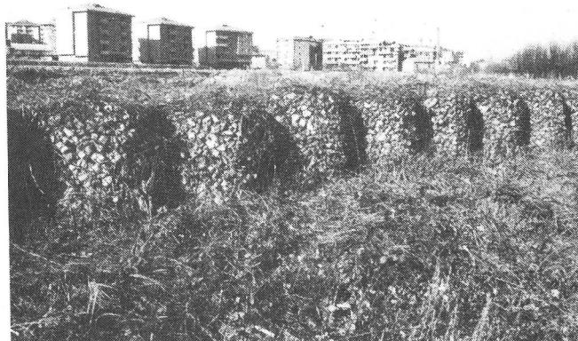
Photo 2 — Le même ouvrage photographié il y a quelques années. La végétation et les dépôts du fleuve ont presque complètement recouvert la structure.
