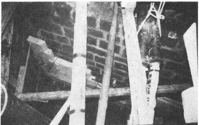
Fig. 6 : Pont de Berne à Fribourg : vue plongeante de l'arrière de la culée avec mur en terre armée en cours d'édification.
