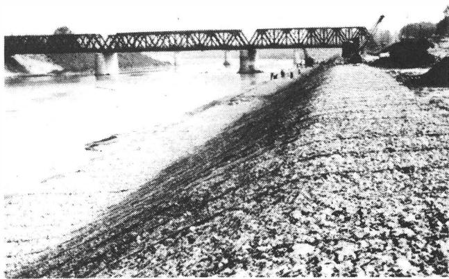
Bild 4: Abdeckung der Dämme eines Flusses mit einem Bauwerk geringen Querschnitts; die Reno-Flussmatzen.
