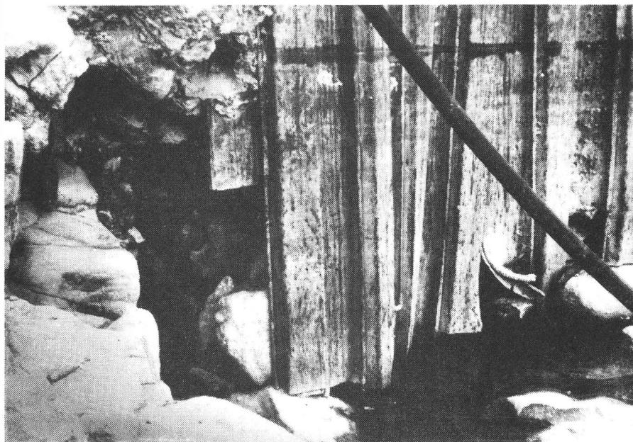
Fig. 7: Oberer Fangdamm von Picote. Ende der Spundwand am Fuss der rechten Talflanke.
