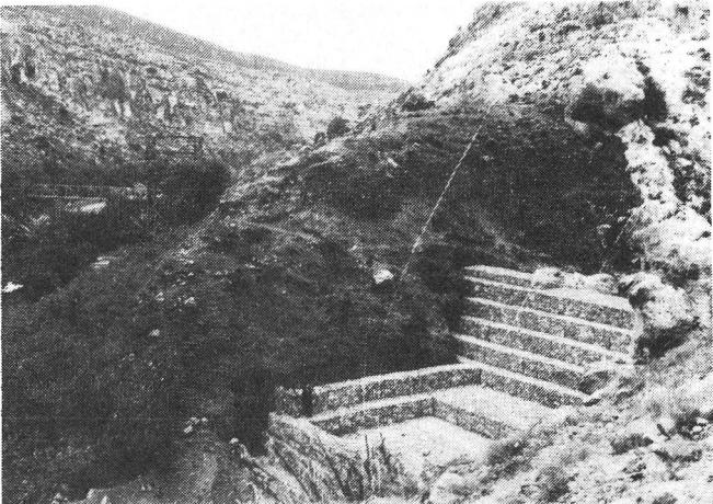
*Photo 10 — Exemple classique de bride pour la régulation d'un cours d'eau en montagne. Il faut remarquer que le bassin de dissipation et le centre de la bride ont été entièrement réalisés en gabions.*
