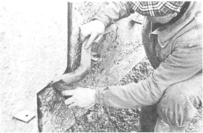
Photo 17: Vertikalfuge mit Einlage aus Schaumstoff
