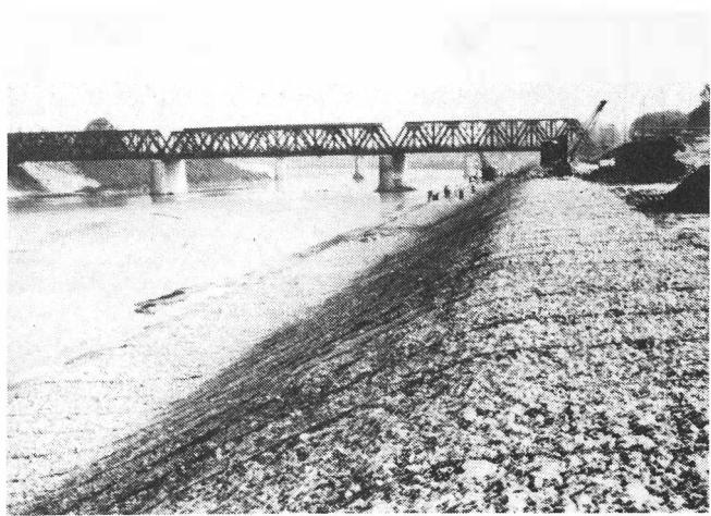
Photo 4 — Exemple de revêtement des berges d'un fleuve avec une structure à section fine : les «Matelas Reno».
