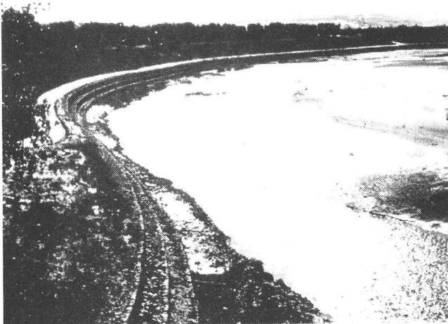
Bild 12: Klassisches Beispiel eines Längsschutzes einer durch Erosion bedrohten Fahrbahn.
