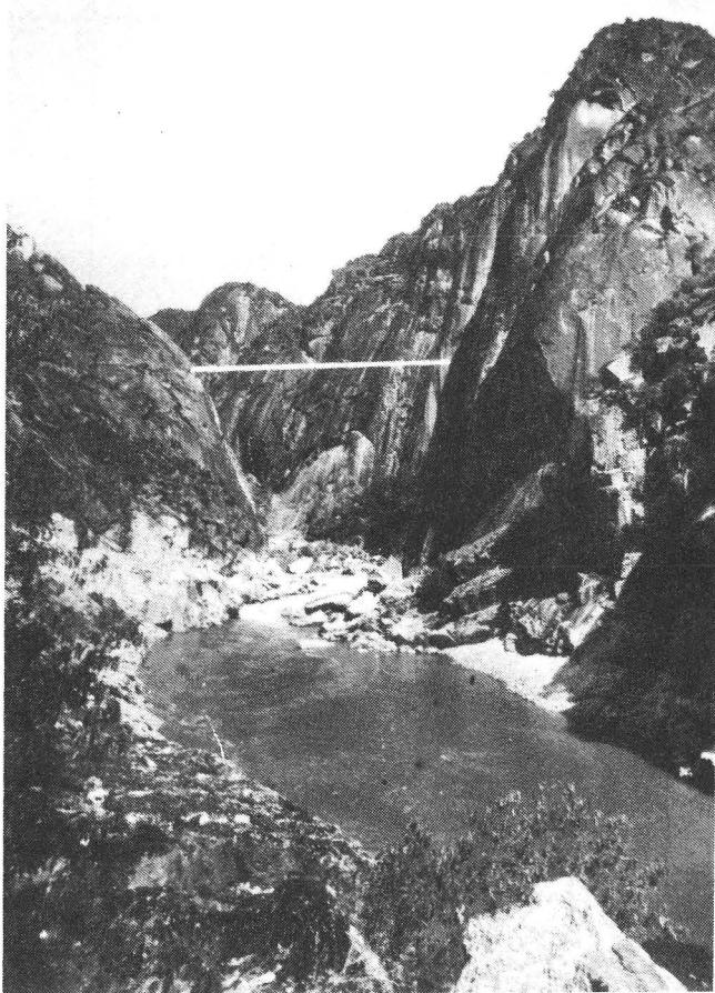
Fig. 1: Spanische Sperrstelle Aldeadávila am Grenzfluss Duero, flussaufwärts gesehen. Der waagerechte Strich bedeutet die Krone der 135 m hohen Bogenstaumauer.
