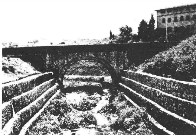
Bild 3: Klassisches Bauwerk grossen Querschnitts aus Gabionen für den Schutz der Dämme eines Flusses.
