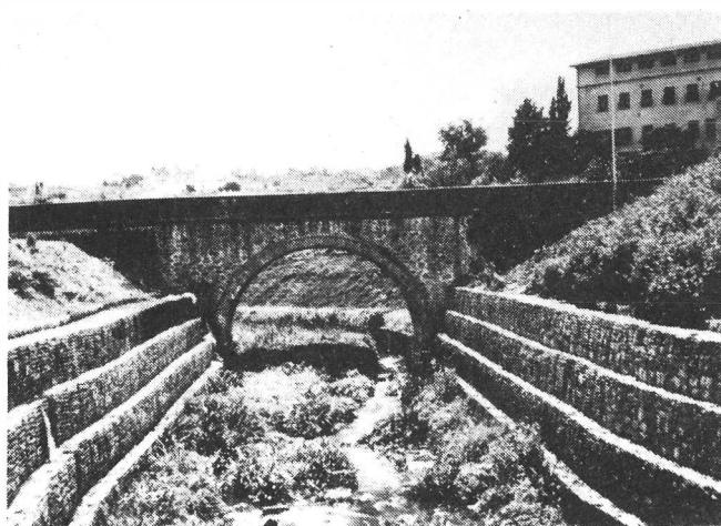
Photo 3 — Exemple classique de structure en gabions à grande section pour la protection longitudinale des berges d'un cours d'eau.
