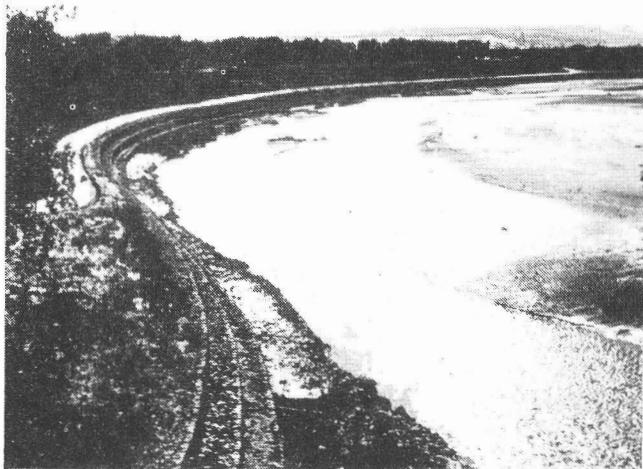
*Photo 12 — Exemple classique d'une vaste protection longitudinale d'une chaussée menacée par l'érosion.*
