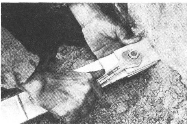
Photo 11 : raccordement des armatures
